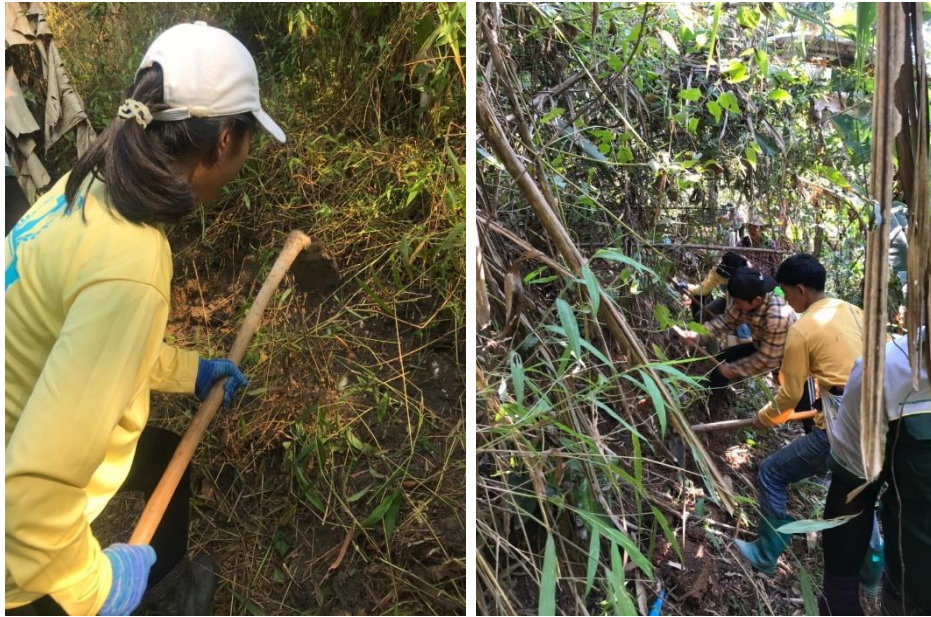
รูปที่ 17 หลังจากการวางระบบน้ำเรียบร้อยแล้วต้องขุดดินเพื่อนำดินมากลบท่อเพื่อป้องกัน การเกิดความเสียหายหากเกิดไฟไหม้ป่า หรือได้รับความเสียหายจากการกระทำของคน
