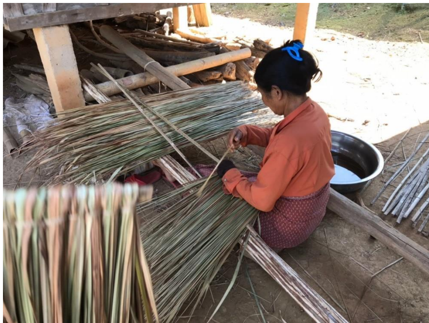
รูปที่ 18 ชาวบ้านทำหลังคาโดยใช้หญ้าคา
